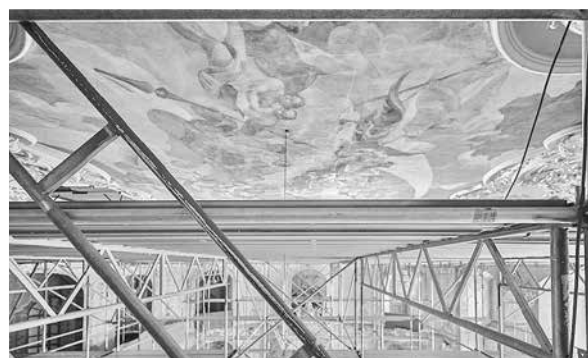
Festsaal mit Untersuchungsgerüst
