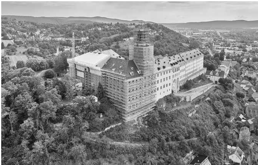
Schloss Heidecksburg mit Baugerüst
