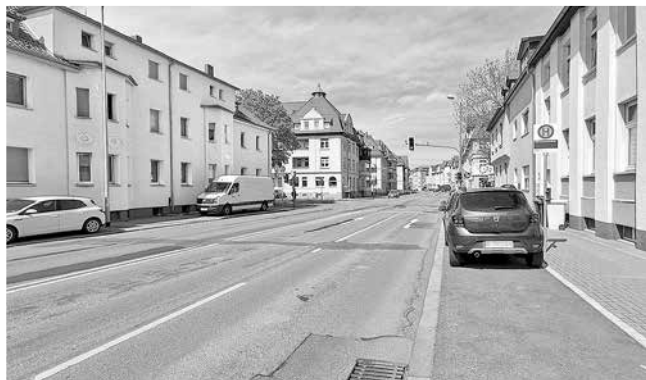
Ursprünglich wurde die Clara-Zetkin-Straße vierspurig angelegt und befindet sich heute baulich und stadtklimatisch in einem schlechten Zustand
