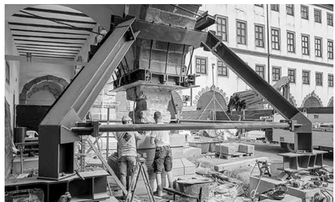
Sanierung eines Arkadenpfeilers
