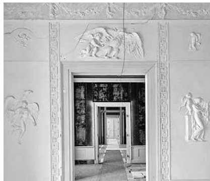
Sanierungsbereich im Westflügel
