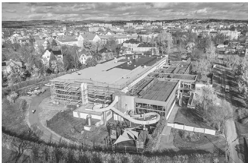
Um das rund 30 Jahre alte Dach des Hofwiesenbads nachhaltig instand zu setzen, musste der Dachaufbau bis zum Stahltragwerk zurückgebaut und neu konzipiert werden
