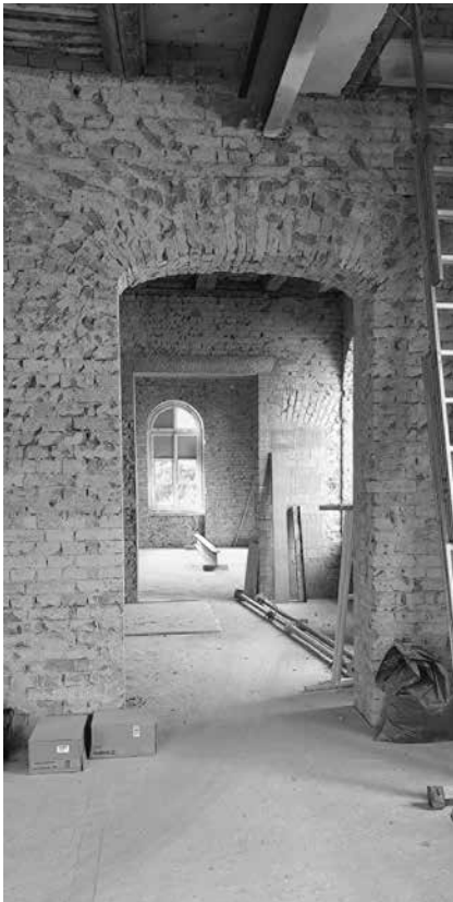
Herstellen neuer Türrdurchbrüche für Flucht- und Rettungswege
