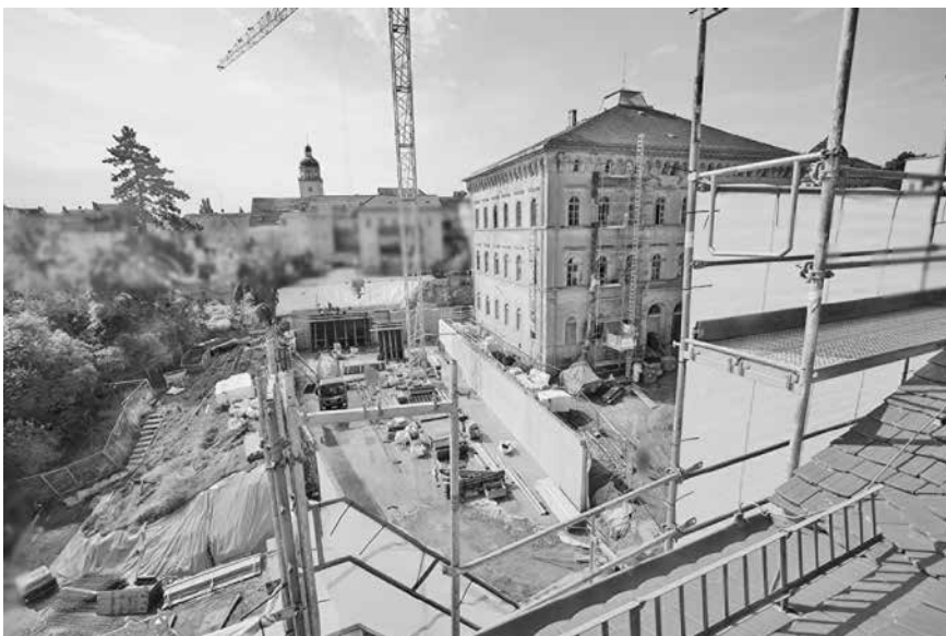
Errichtung des LAB-Bereichs im Neubau, Baustand August 2025
