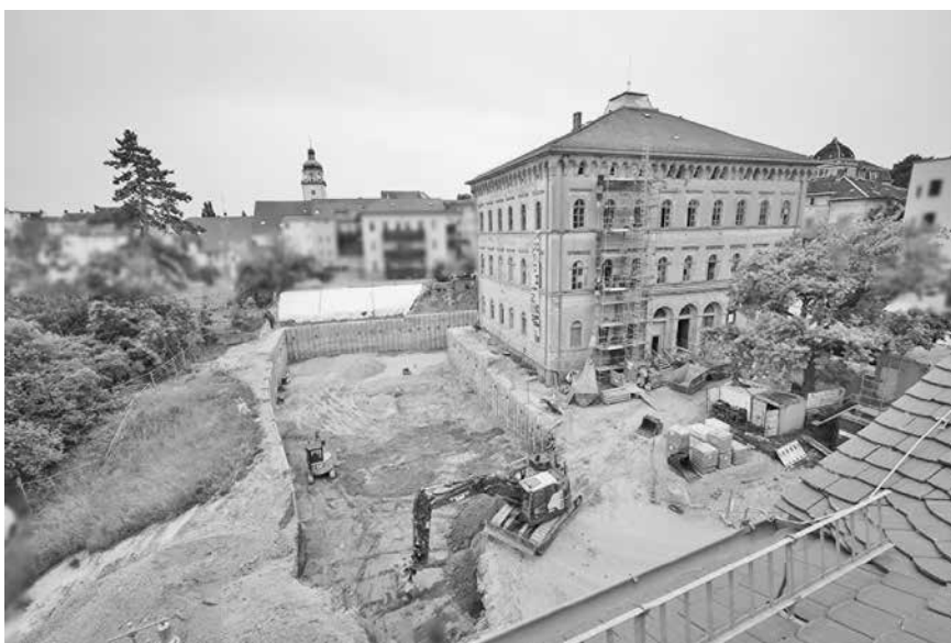
Aushub der Baugrube im Juni 2025
