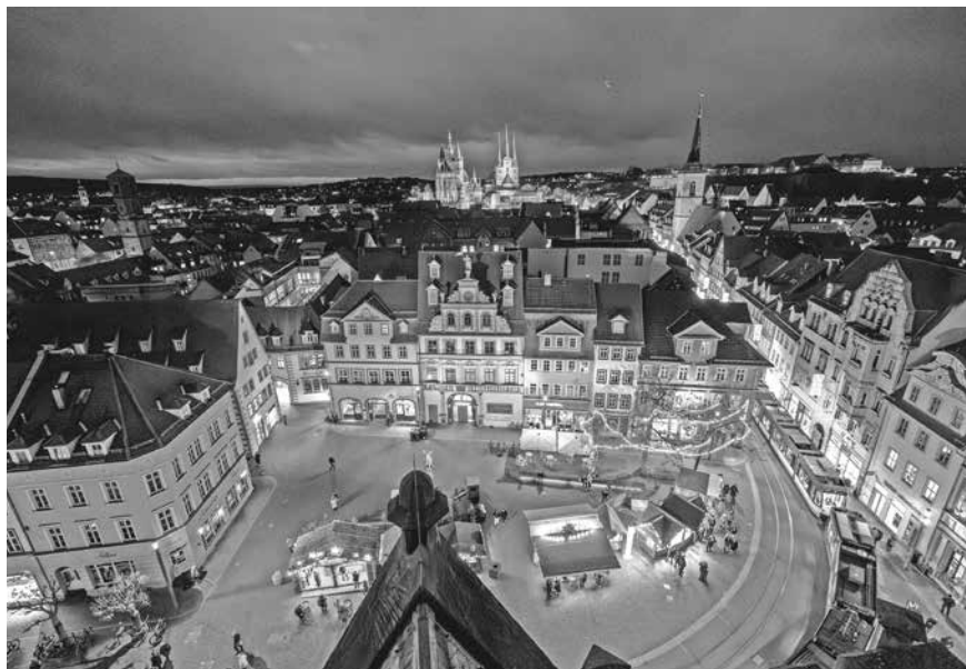
Zentrale Innenstadtbereiche sollen auch künftig über eine gute Ausleuchtung verfügen, die dem Sicherheitsbedürfnis der Bevölkerung gerecht wird
