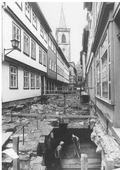
In den Jahren 1985/1986 wurde die Krämerbrücke umfassend saniert Foto: Stadtarchiv Erfurt
