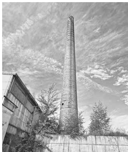
Der alte, 60 Meter hohe Schornstein auf dem Baugelände wurde inzwischen gesprengt und hat Platz gemacht für den Neubau
