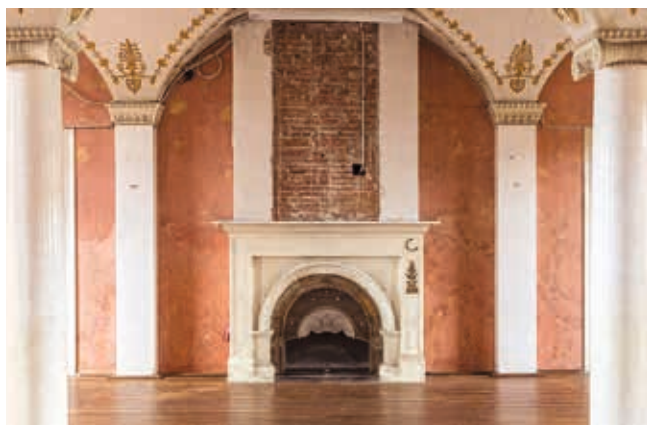
Schloss Heidecksburg in Rudolstadt, Kamin mit Heiztechnik des späten 19. Jahrhunderts Foto: STSG, Thomas Müller
