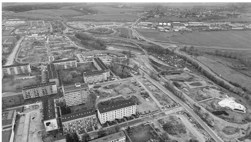
Bauzustand Gesamtgelände Gartenstadt und Augarten
