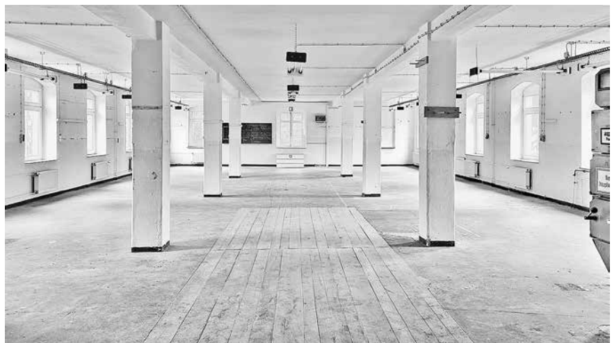
Künftiger Depotbereich in der alten Porzellanfabrik
