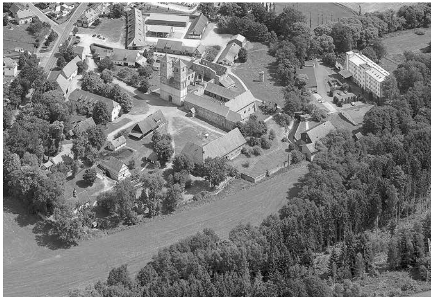
Kloster Veßra, künftiges Depotgebäude oben rechts im Bild
