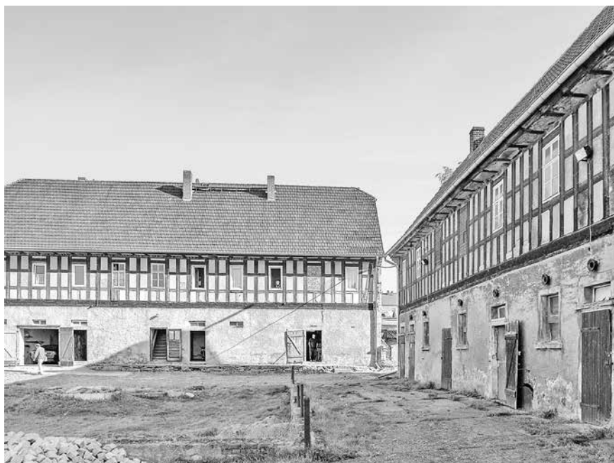
So wie diese Nebengebäude warten viele Vierseithöfe im Altenburger Land auf eine ressourcenschonende Instandsetzung
