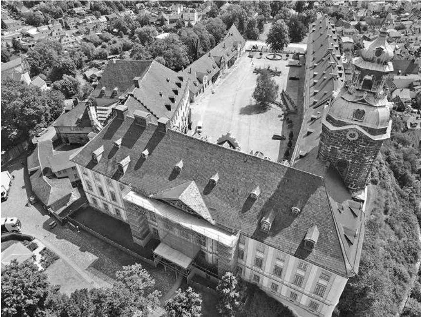
Schloss Heidecksburg in Rudolstadt mit Sicherungsgerüsten
