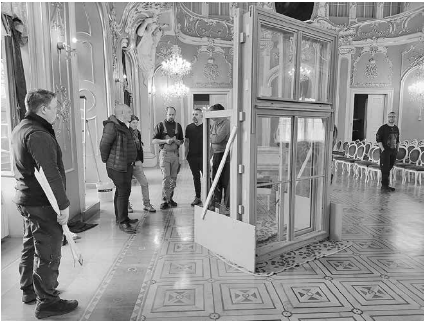
Begutachtung eines Musters für 70 Fenster auf Schloss Sondershausen
