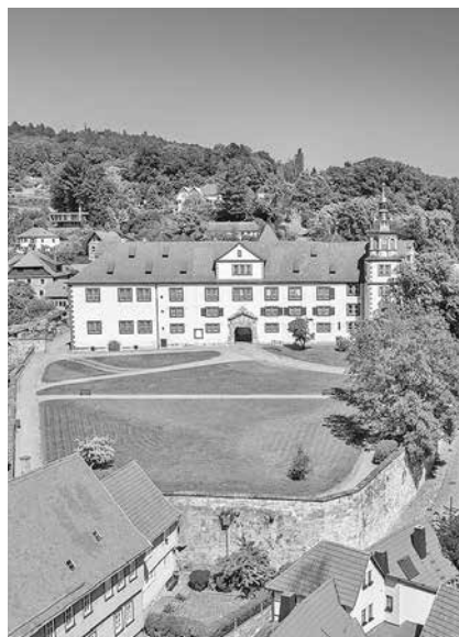
Schloss Wilhelmsburg Schmalkalden – Südflügel-dach und Stützmauern werden saniert Foto: Schatzkammer Thüringen, Philipp Hort
