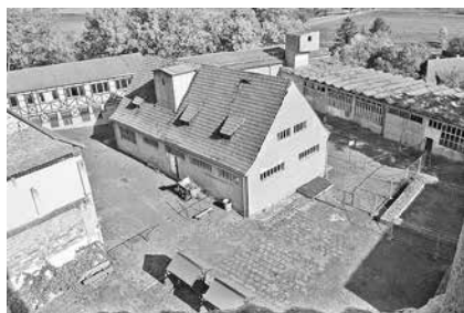
Kloster St. Wigbert in Göllingen, ehemaliges Fabrikgebäude als künftiger Ausstellungsort
