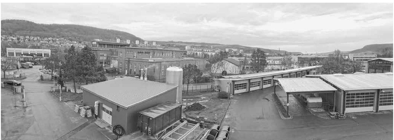
Gesamtanlage auf dem KSJ-Betriebsgelände
