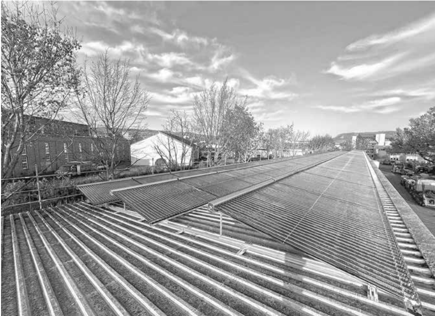
Solarthermieanlage mit 270 kW Leistung auf einer Fläche von 700 m 2
