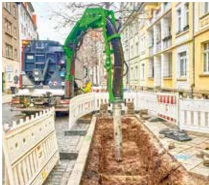
Der Einsatz von Saugbaggern kann Wurzeln schonen und hilft auch bei der Vergrößerung von Baum-scheiben in Leitungsnähe
