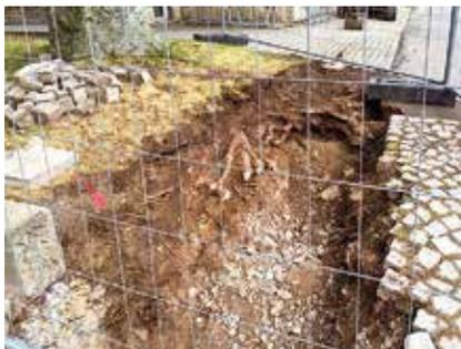
Gut geplante Baumaßnahmen mit einem Baumschutzkonzept sollen große Eingriffe in den Wurzelraum verhindern. Ein Wurzelverlust wie hier an einer wertvollen Buche soll der Vergangenheit angehören.
