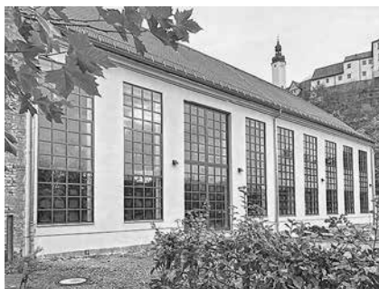
Orangerie, Südfassade mit neu eingebauten Orangeriefenstern Foto: STSG, Franz Nagel
