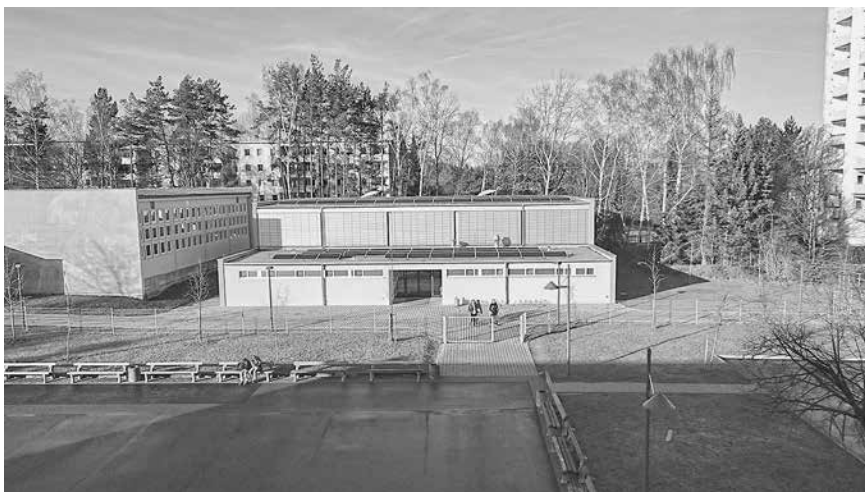
Nicht nur Schulen, sondern auch Turnhallen im Saale-Holzland-Kreis werden zunehmend zur nachhaltigen Energiegewinnung genutzt. So wurde 2015 eine Photovoltaikanlage auf der Sporthalle in Hermsdorf, der zweitgrößten Stadt des Landkreises, errichtet, ebenfalls gemeinsam mit der BürgerEnergie-Genossenschaft. Fotos: BürgerEnergie eG
