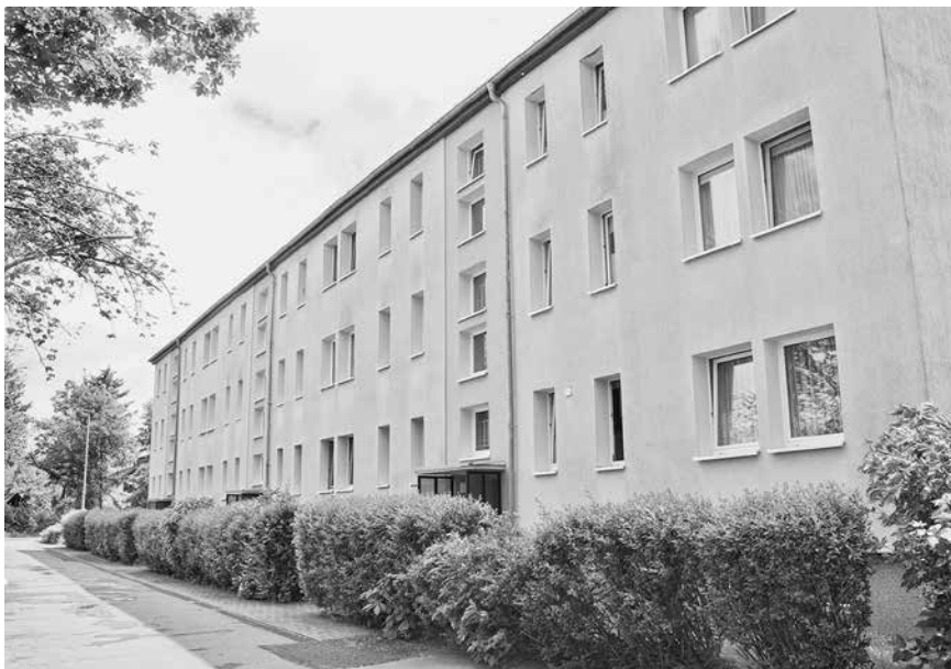
Wohnblock mit 18 Wohneinheiten in Haßleben, Baujahr 1966, nach 1990 saniert
