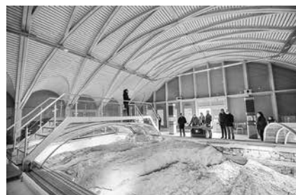
Zur dauerhaften Konservierung der wertvollen Zeugnisse urzeitlichen Lebens beherbergt die Schutzhalle auf der Steinrinne Bilzingsleben ein verglastes Gewölbe über dem Knochenpflaster Foto: Tino Trautmann
