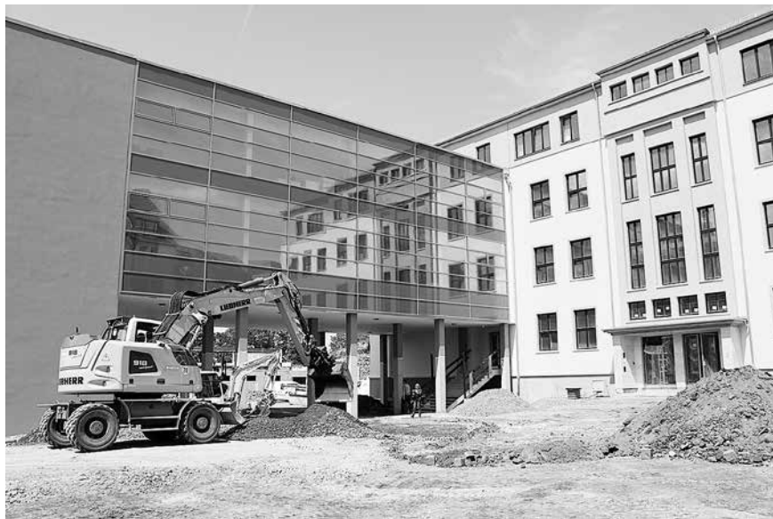
Das neue Oberstufengebäude des Humboldt-Gymnasiums Nordhausen baut die Service Gesellschaft
