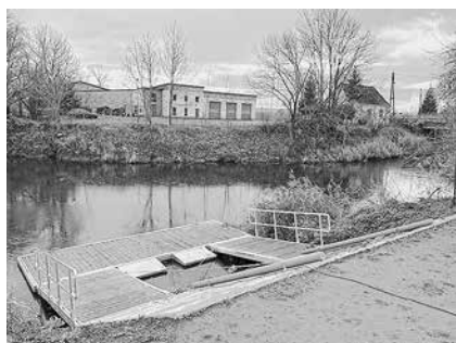
Neuer Schwimmsteg in Gerstungen
