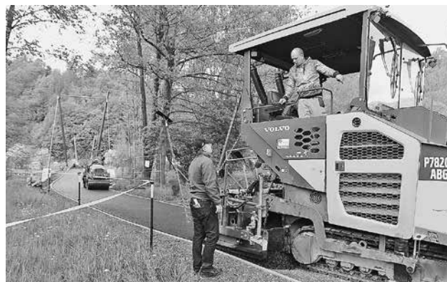
Mit den Asphaltarbeiten wird im Mai die radgerechte Zufahrt zur Brücke hergestellt, der Gussasphalt auf der neuen Radwegebrücke liegt bereits. Foto: Jasmin Krüger
