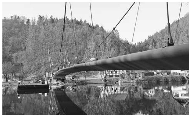
Gut eingebettet in die Landschaft präsentiert sich die Brücke seit 24. Februar, nachdem die 7 Meter langen Brückenbauteile eingehoben und zunächst miteinander verschlossen wurden. Foto: Martin Modes
