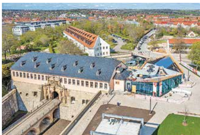
Am neuen Empfangsgebäude, dem Petersberg Entree außerhalb der Buga-Ausstellungsfläche, werden letzte Arbeiten durchgeführt
