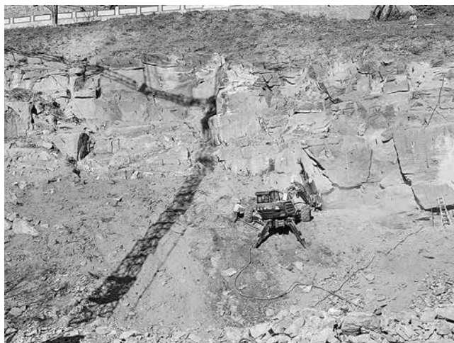
Setzen von Bohrkern im unteren Bereich
