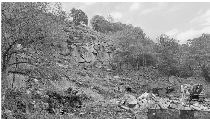
Phase 1: Beräumen loser Gesteinsschichten
