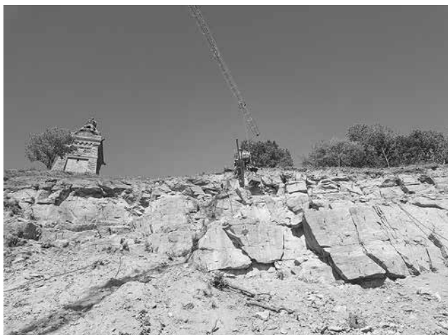
Setzen von Bohrkern im oberen Bereich
