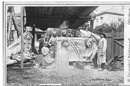
Steinmetz Werkstatt auf der Baustelle Foto: Landesarchiv Thüringen
