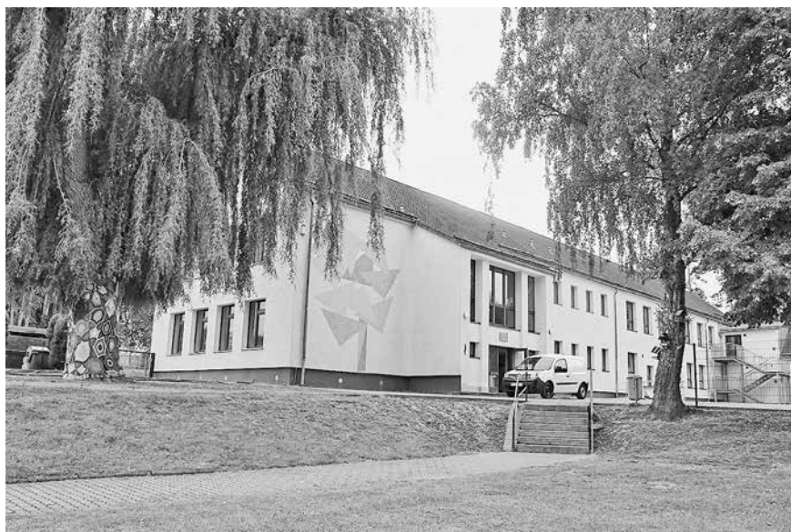
Grundschule Martinroda musste 2019 – 2020 wegen überhöhter Naphthalinwerte saniert werden
