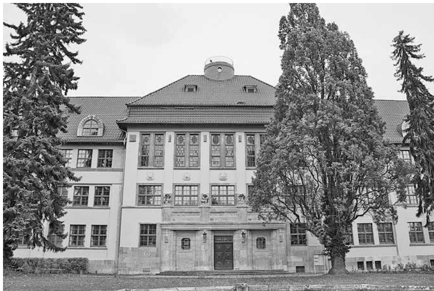
Zu den Prestige-Objekten der derzeitigen Sanierungsarbeiten im Ilm-Kreis gehört das ehemalige Neideck-Gymnasium in Arnstadt. Hier soll nach Fertigstellung die Bechstein-Regelschule einziehen.
