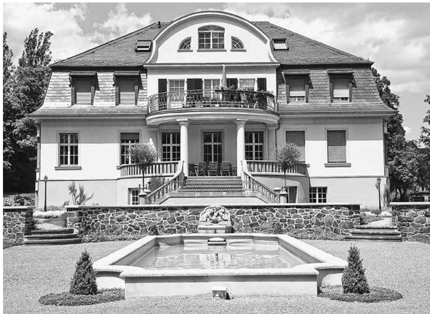
Die Mitte der 1920er Jahre errichtete Villa des Lederfabrikanten Franz Prasse in Weida zählt heute zu den schönsten Grundstückensembles im Landkreis Greiz. Die aufwändige denkmalgerechte und detailgenaue Sanierung des Herrenhauses im Stile des „Art Déco“ wurde 2005 mit dem Denkmalschutzpreis des Landkreises Greiz prämiert. Heute beherbergt das Gebäude Veranstaltungsräume und Privatwohnungen.
