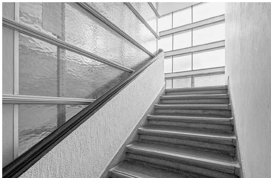
Blick ins Treppenhaus der Schaefer-Klinik.
