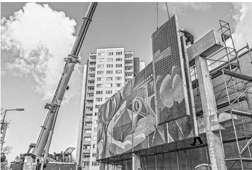
Das Wandbild wird wieder angebracht
