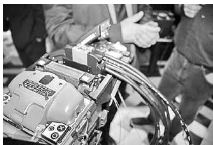
Glasfasertechnik Breitband Foto: Kyffhäuser Nachrichten, Karl-Heinz Herrmann
