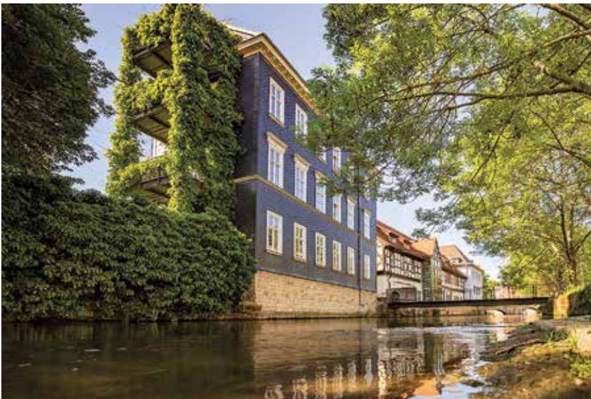
Um den Kühlungseffekt zu erhöhen, werden Fassadenbegrünungen, wie am Erfurter Fischersand, angestrebt. Aber auch Wasserläufe oder Brunnen sind wertvolle Elemente.
