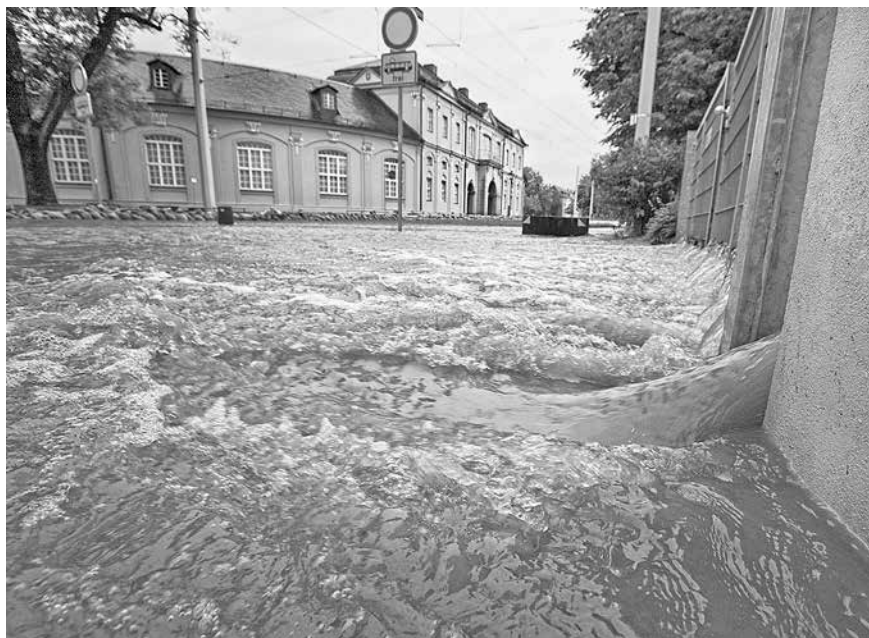
Das Hochwasser der Weißen Elster im Juni 2013 hat enorme Schäden an der Orangerie verursacht Fotos: Stadtverwaltung/Steffen Weiß
