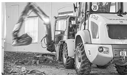
Bodenaushub mit schwerem Gerät nach dem Hochwasser innerhalb der Orangerie
