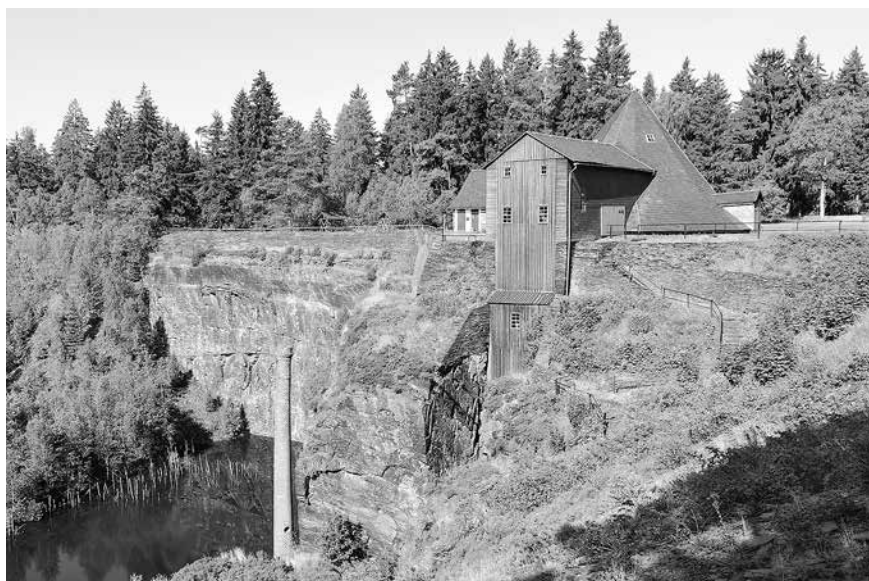
Ein Denkmal von europäischem Rang: Der Pferddegöpel am Technischen Denkmal Historischer Schieferbergbau in Lehesten ist die letzterhaltene dieser Fördermaschinen und ein Denkmal von europäischem Rang. Im Zuge der Recherchen fanden Siegfried Scheidig und Frank Barteld heraus, dass dieser Pferddegöpel auf das Jahr 1862 datiert werden muss – damit ist er etwa 20 Jahre jünger als bisher angenommen. Auf dem Lehestener Gelände war es damals bereits der dritte Göpel, der eingerichtet wurde. Foto: Frank Barteld
