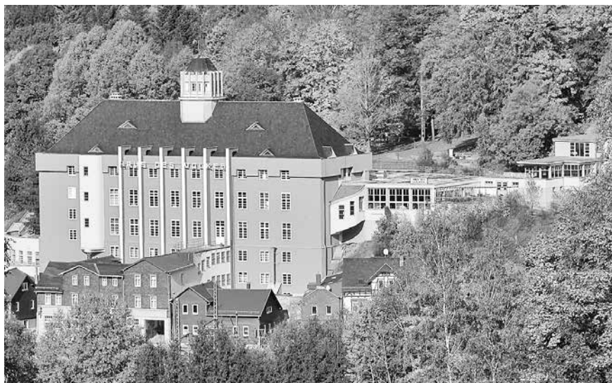
Das Haus des Volkes in Probstzella erstrahlt heute wieder im originalen Bauhaus-Glanz. Eingeweiht wurde es am 30. April 1927, seit zehn Jahren hat es nach langem Leerstand dank der neuen Eigentümer wieder überregionale Strahlkraft entwickelt.
