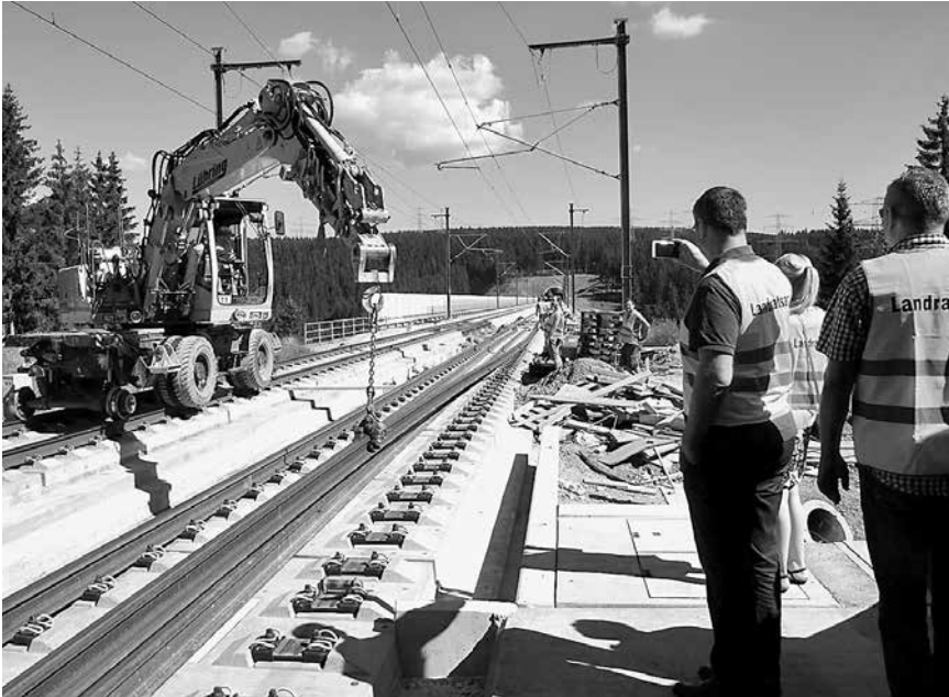
Wenige Wochen vor Inbetriebnahme werden – wie hier auf der Oelzetalbrücke – die letzten Schienen verlegt Foto: Peter Lahann
