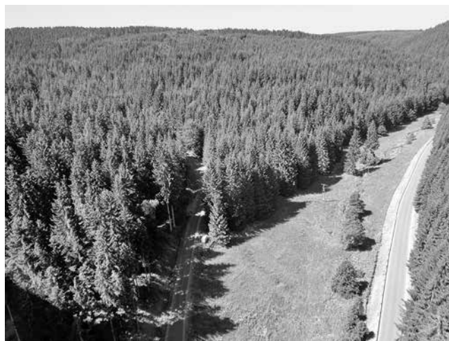
Der Blick, der sich den ICE-Zugreisenden künftig von der Massetalbrücke aus ins Massetal in Richtung Masserberg bietet Foto: Martin Modes
