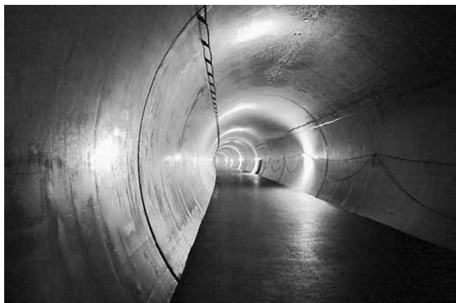
Blick in das Gewölbe des befahrbaren Rettungsstollens am Fleckberg-tunnel Foto: Peter Lahann
