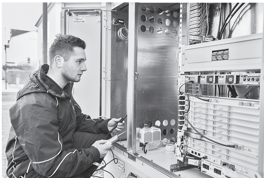
Anschlussarbeiten der Stadtwerke Mühlhausen an einem der neuen Kabelverweigerkästen
