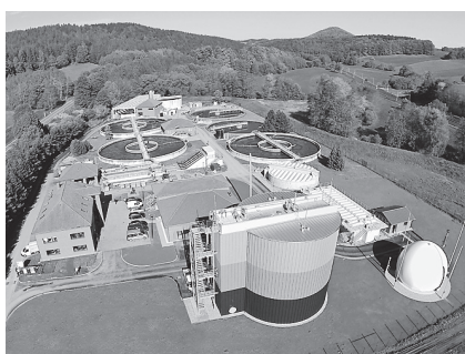
Abwasserentsorgung heute: Luftaufnahme der Kläranlage Leinetal bei Uder
