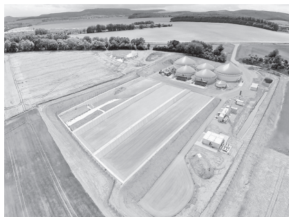
Energieversorgung heute: Die Biogasanlage Weißenborn-Lüderode speist jährlich etwa 30 Mio. kWh Biogas mit Erdgasqualität in das regionale Erdgasnetz ein
