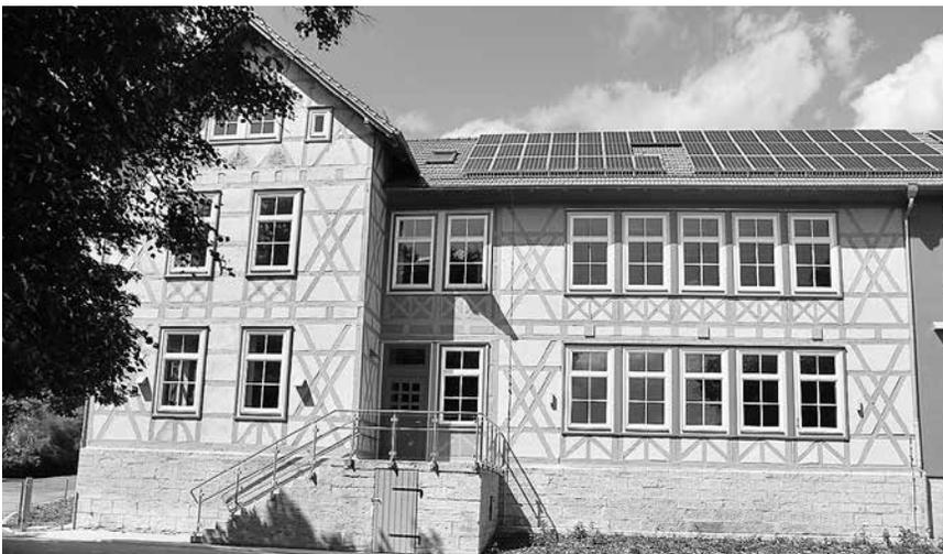
Wie viele andere Bildungseinrichtungen im Landkreis wurde die Grundschule in Walldorf grundhaft saniert. Eine Photovoltaik-Dachanlage mit insgesamt 76,68 kWp auf Schule und Sporthalle senkt die CO<sub>2</sub>-Emission nachhaltig.
