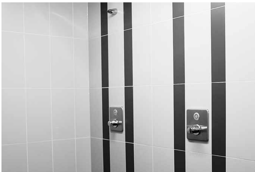
... zeigen sich die sanitären Bereiche
