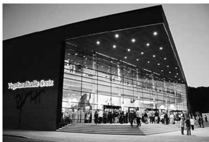
Die modernste Kulturstätte im Vogtland Foto: Vogtlandhalle
