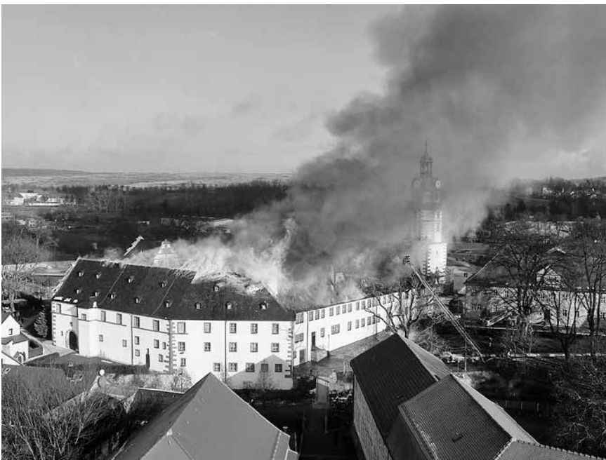
Ein Großbrand zerstörte am 26. November 2013 große Teile des Ohrdruffer Schlosses Ehrenstein. Die Flammen und Rauchschwaden waren weithin sichtbar.
