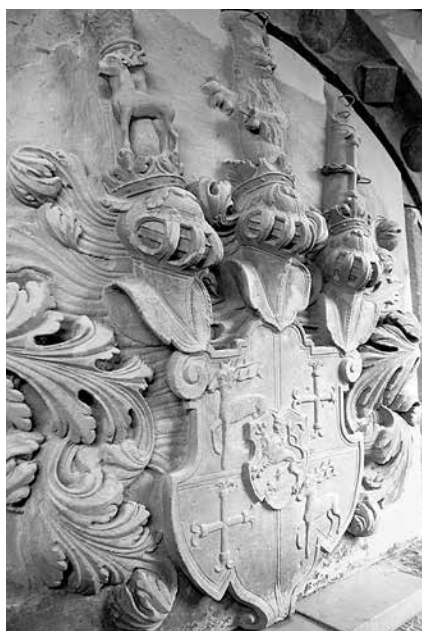
Erste Wappen konnten bereits restauriert werden, sind aber noch nicht wieder sichtbar
