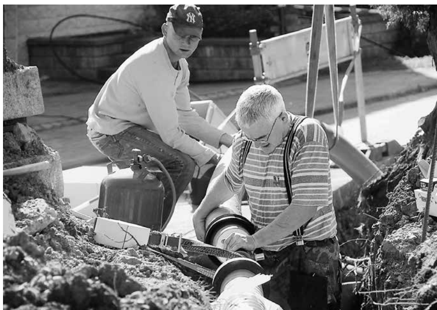
Beim Verlegen des Nahwärmenetzes packen viele im Dorf mit an
