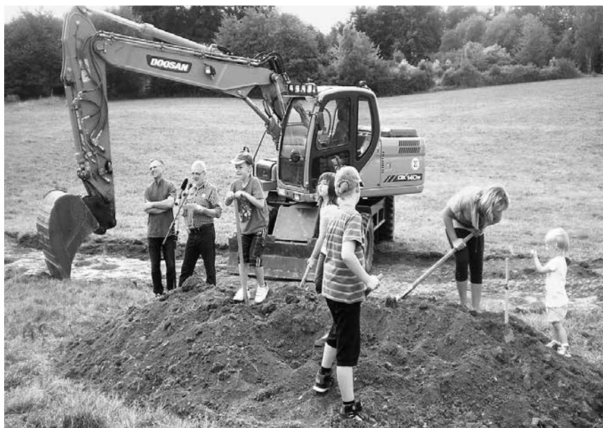
Positive Perspektiven auch für die jüngeren Generationen: Den ersten Spatenstich für die Nahwärmeleitung in Bechstedt vollzogen die Dorfkinder am 13. September 2012
