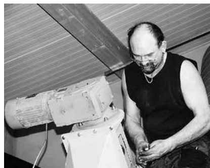
Bodo Fuchs bei Wartungsarbeiten an der Hackschnitzelzuführung Foto: Burkhard Kolbmüller
