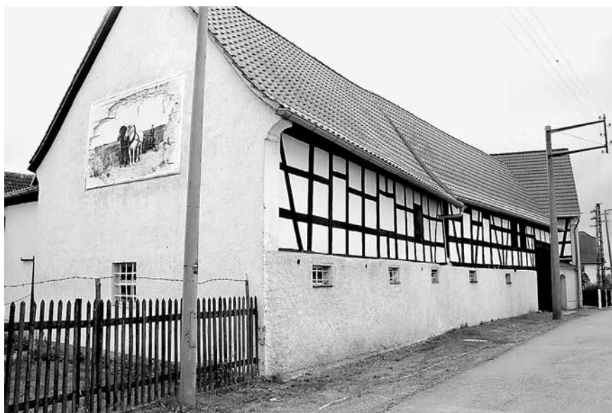
Der Vierseithof Naulitz 12 wurde im Jahr 1728 errichtet und gilt als ältestes Gebäude im Ort Fotos: Stadtverwaltung/Pucher
