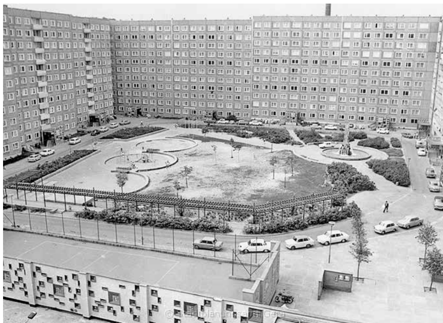
So präsentierte sich der „Sonnenhof“ im Stadtzentrum um 1978. In dem heute kaum wiederzuerkennenden Quartier wurden zwischen 1998 und 2013 rund 130 Wohnungen zurückgebaut. In diesem Zeitraum investierte die kommunale Wohnungsbaugesellschaft „Elstertal“ mbH in mehreren Bauabschnitten rund 20,8 Millionen Euro in diesen Standort. Mehr als die Hälfte davon kamen als Fördermittel von Bund und Land Thüringen. Foto: Stadtverwaltung/Hertel
