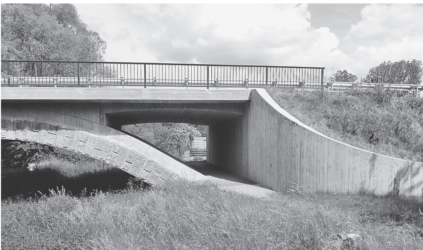
Teilansicht der neuen Brücke über die Taft
