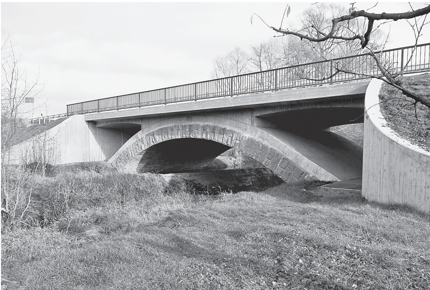
Neubau: Von der Bahnbrücke zur Straßenbrücke
