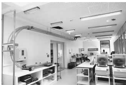
Eine intelligente Rohrpostverbindung sorgt für kurze Wege und Zeitersparnis zwischen dem Klinikum und dem Medizinischen Zentrallabor im MEDICUM Foto: Klinikum Altenburger Land GmbH
