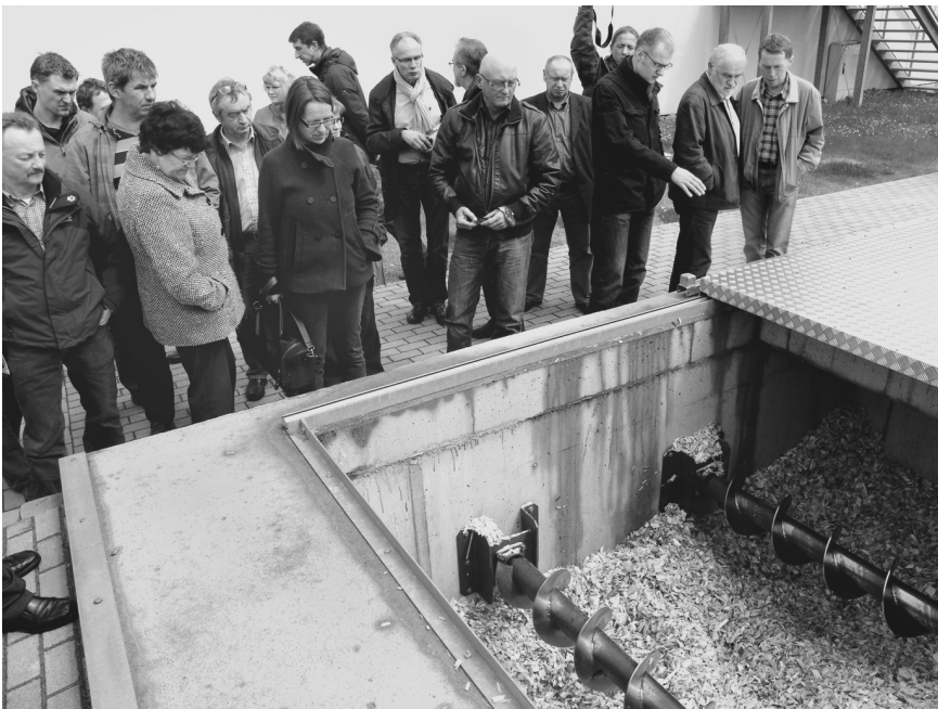
Ein Beispiel für eine begonnene Energiewende stellt das kommunale Biomasseheizwerk in Breitung/Werra dar
