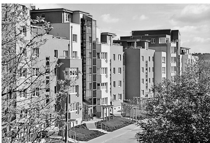
Die Sanierung der südlichen Eiselstraße wurde mit dem Deutschen Bauherrenpreis 2004 ausgezeichnet Foto: Andreas Vieweg
