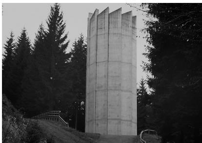
Über diesen Abluftschlot werden im Brandfall die hochgiftigen Brandgase nach außen abgeführt. Direkt unter dem Schlot befindet sich die Fahrbahnmitte der beiden Röhren.
