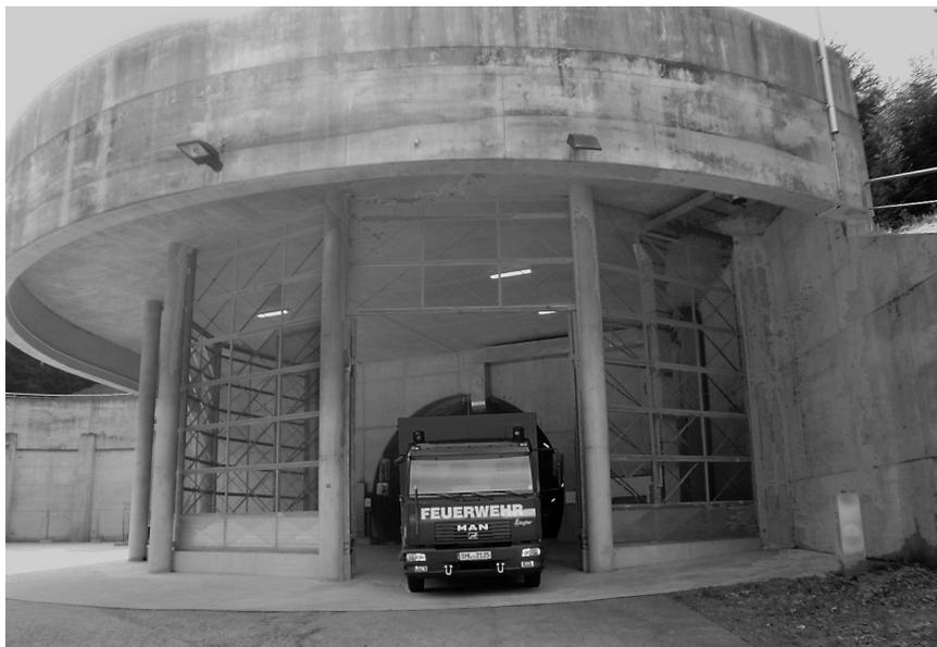
Das Zugangsgebäude zu einer Luftaustauschzentrale (LAZ) von außen. Auch von hier können die Feuerwehren sich einen Zugang in den Tunnel verschaffen. Hierzu ist rechts ein Feuerwehrschrankschloss vorhanden.
